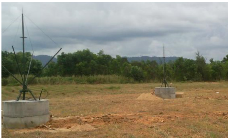
FIGURA 3. Instalación antena y soporte Rohde and Schwarz
